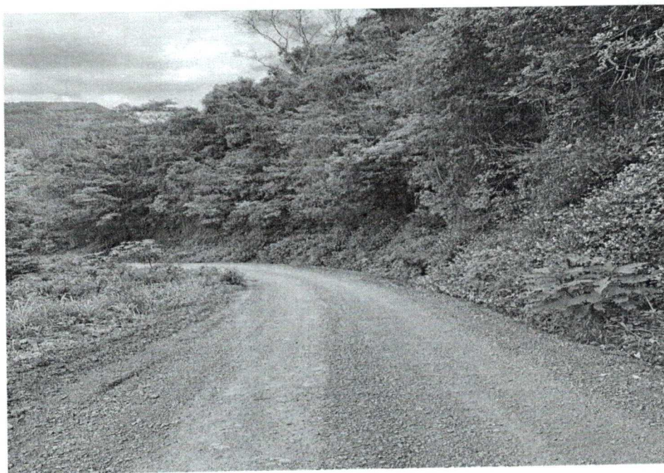
Falta de largura para pavimentação, lado esquerdo possui barranco íngreme, lado direito possui talude íngreme.
