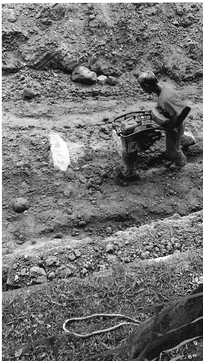
Figura 2 - Compactação Mecânica "Sapo"
