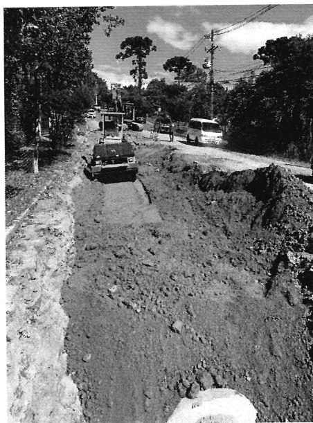
Figura 3 - Compactação Mecânica - Rolo Compactador
