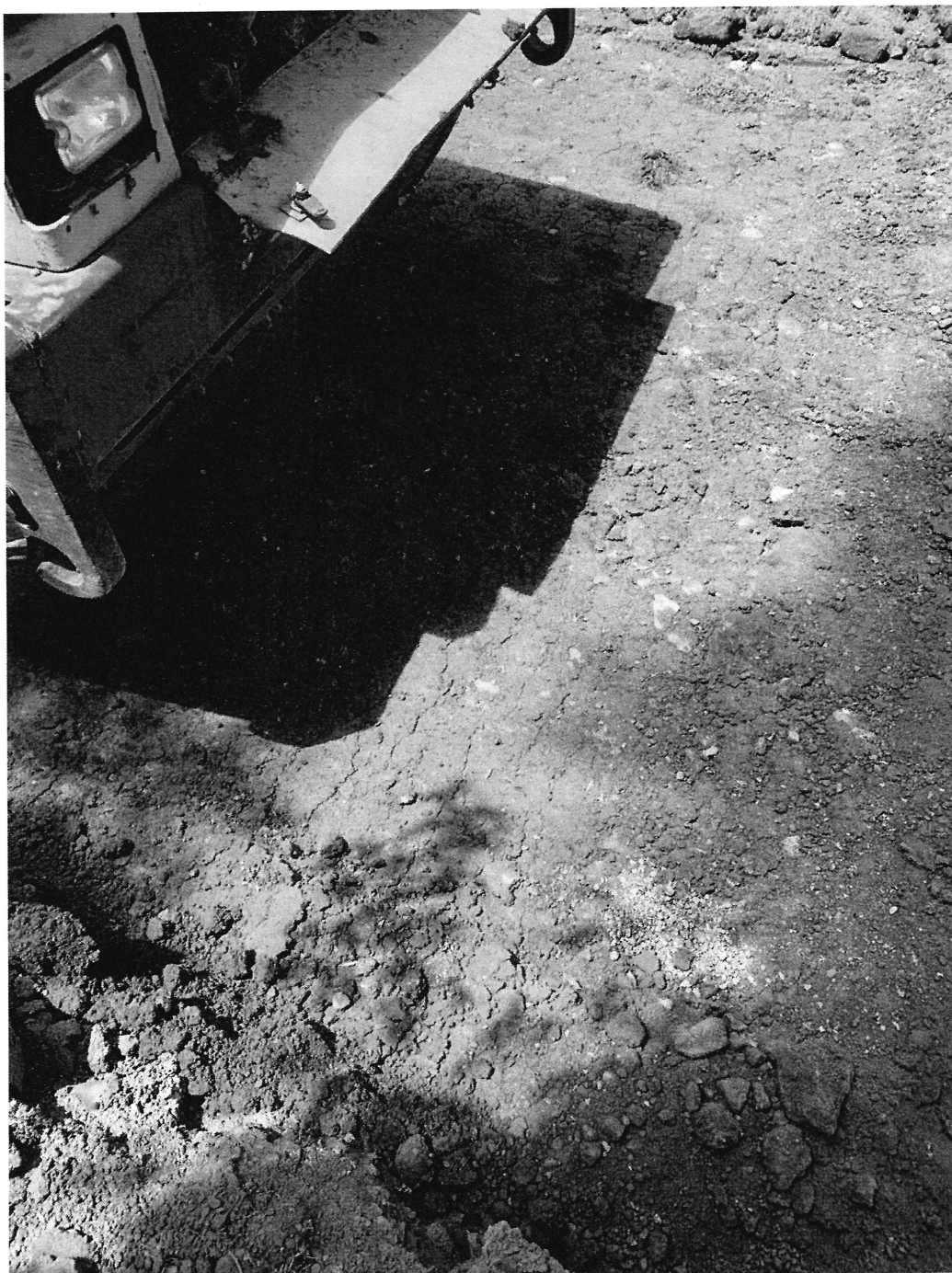
Figura 5 - Presença de fissuras das deformações
