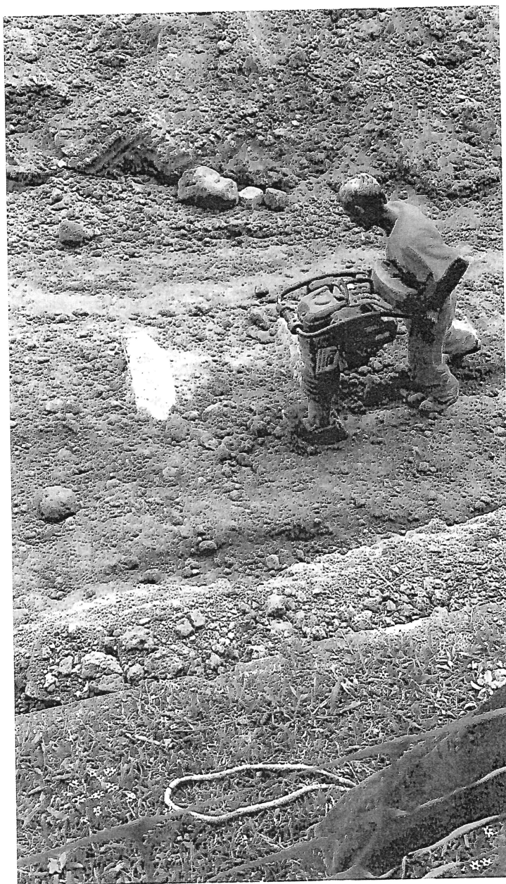
Figura 2 - Compactação Mecânica "Sapo"
