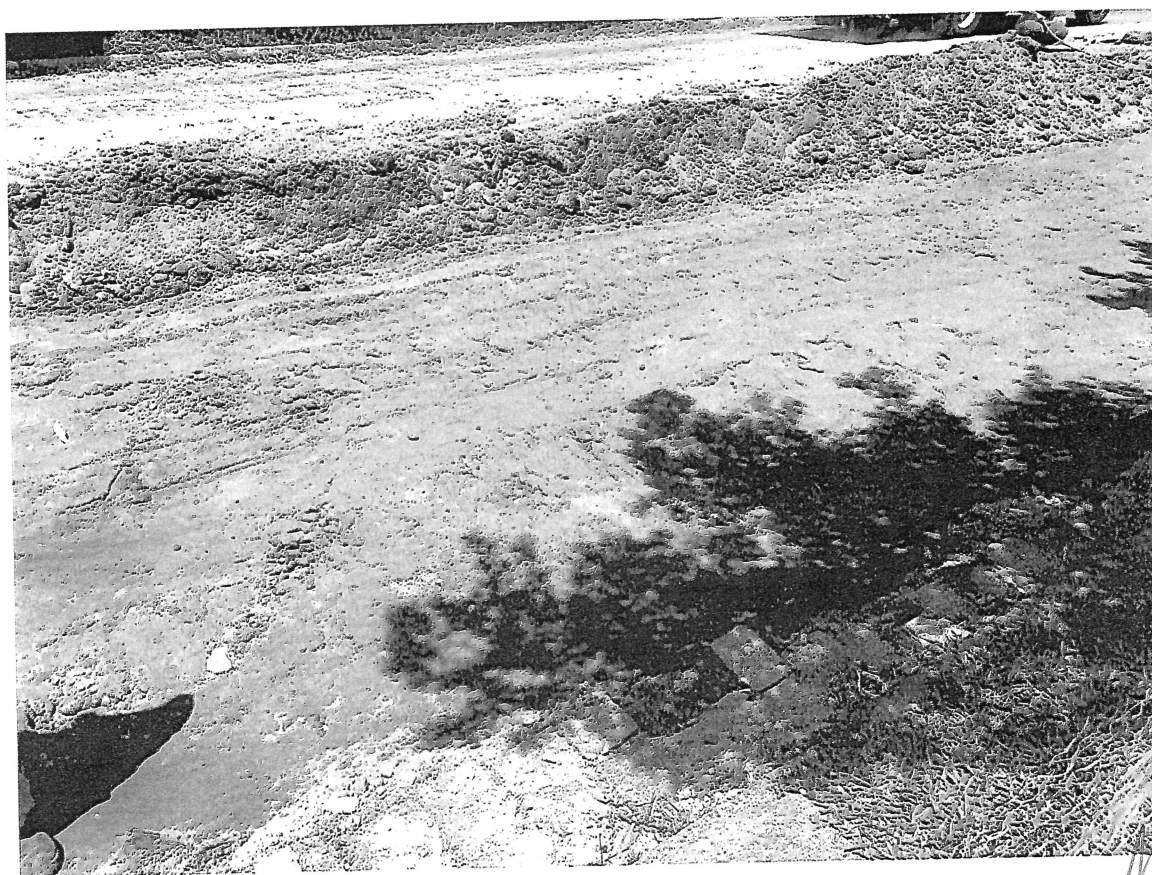
Figura 4 - Presença de deformações excessivas - "borrachudo"
