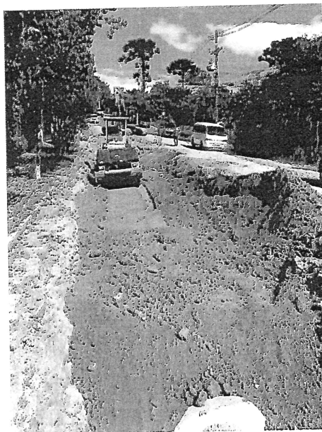
Figura 3 - Compactação Mecânica - Rolo Compactador
